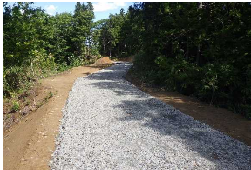
林道（林業専用道）新設
