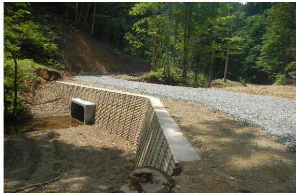
林道（林業専用道）開設
