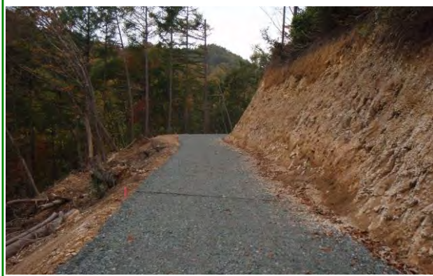
林道（林業専用道）開設
