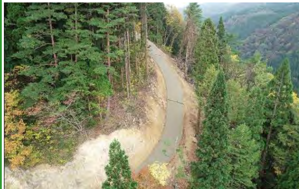
林道（林業専用道）開設
