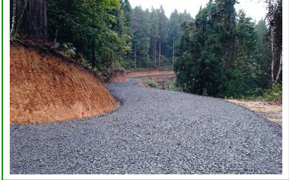
林道（林業専用道）新設
