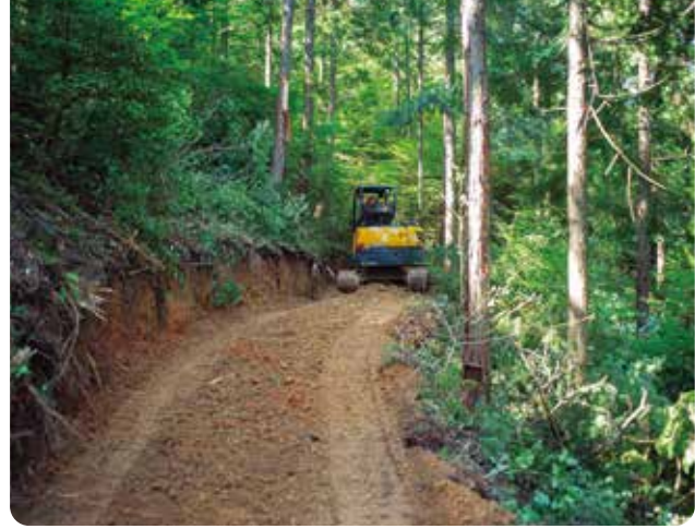
森林作業道の整備
