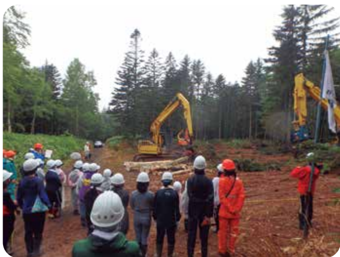
校舎の建築材料となる木材の伐採現場の見学
