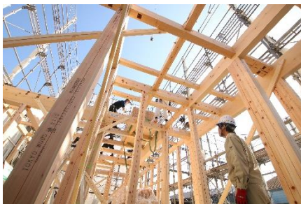
TOKYO WOODの家 建築の様子
