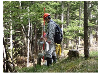
林業専用道予定路線をハンドレベルにて勾配を測りながら踏査
