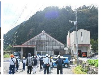
木質チップボイラー・小型ガス化発電施設
