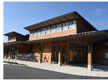
西粟倉村役場庁舎の全景
