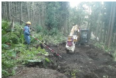
研修生がグラブバケット装着重機を操作して作業道を作設
