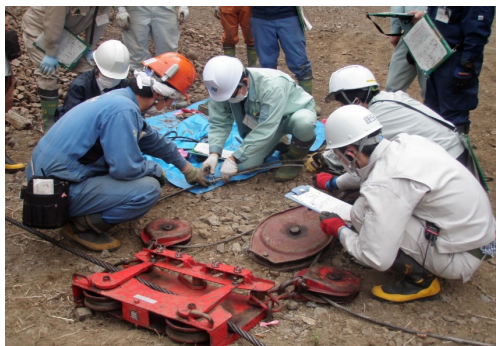
各ラインへの搬器の組み付け
