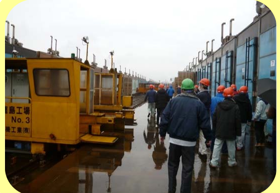
200基以上が並ぶ木材乾燥施設を見学 (中国木材株式会社鹿島工場)
