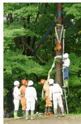
構内で先柱の架設実習
