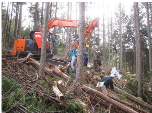
スイングヤーダによる集材作業
