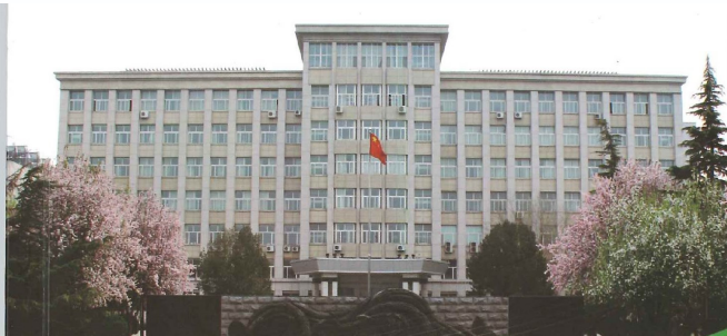
中国・国家林業局管理幹部学院 本庁舎（北京市大興区黄村）
