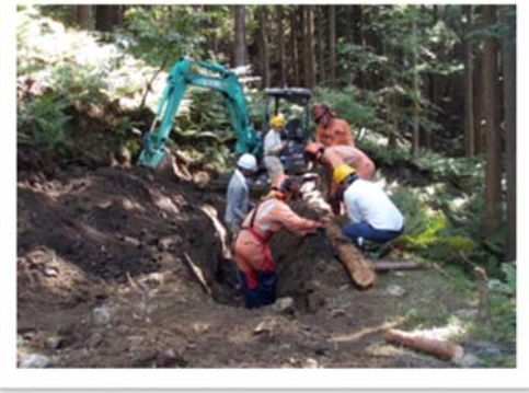
改修作業（路肩に丸太を設置）
