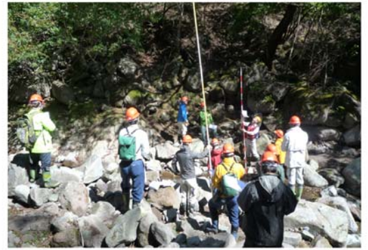
溪間工の現地検討実習
