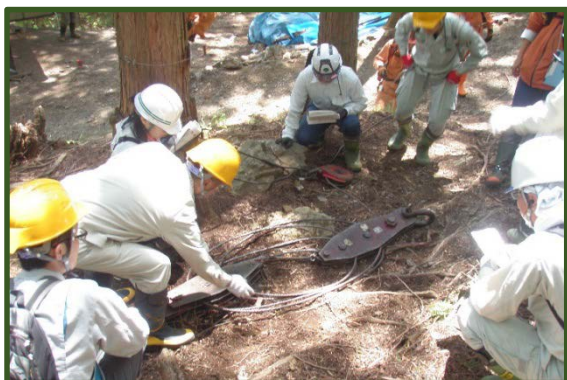
ヒールブロックの設置作業
