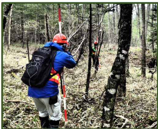
林業専用道予定路線をハンドレベルにより勾配を測りながら踏査
