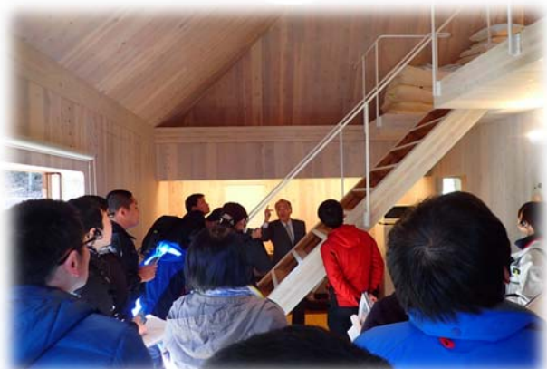
壁・天井・階段までCLTで作られた実験棟
