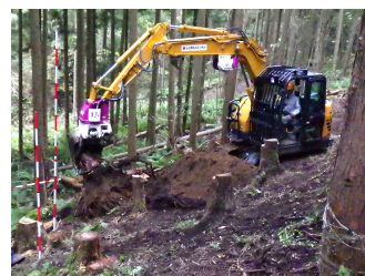
伐根や表土を利用し作設
