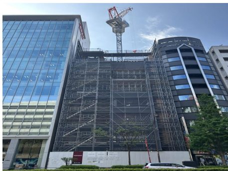
【REVZO新橋 完成パース、工事写真】
