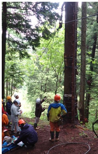
主索の張り具合を振動波法で確認
