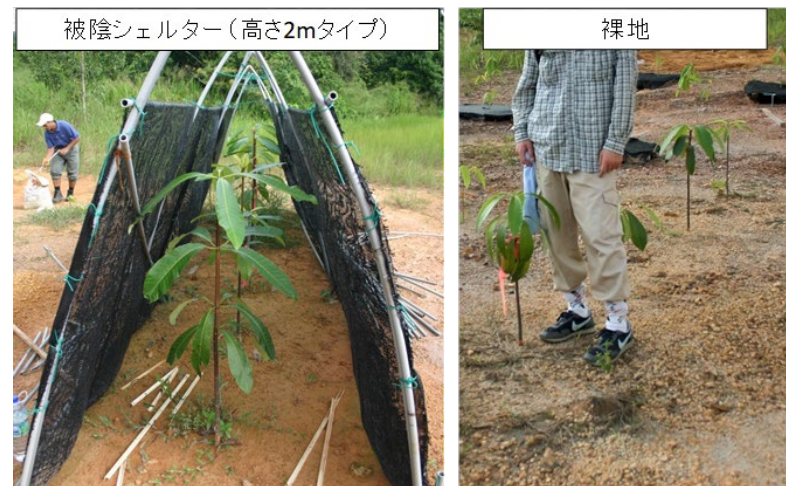
(図2) 被陰シェルターを用いた植栽手法
