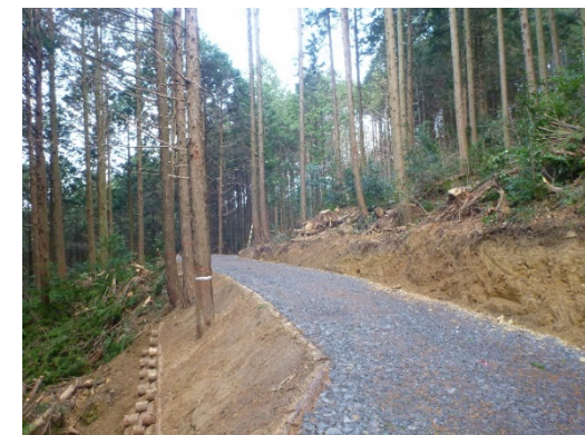
(図2) 丸太組工法(のり留工)の設置例 (佐賀県唐津市)
