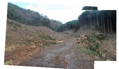
↑ 地拵えの完了状況
