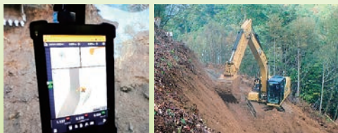
ICT建機における モニター画面
