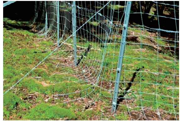
写真2-14 金属柵のスカートネット
