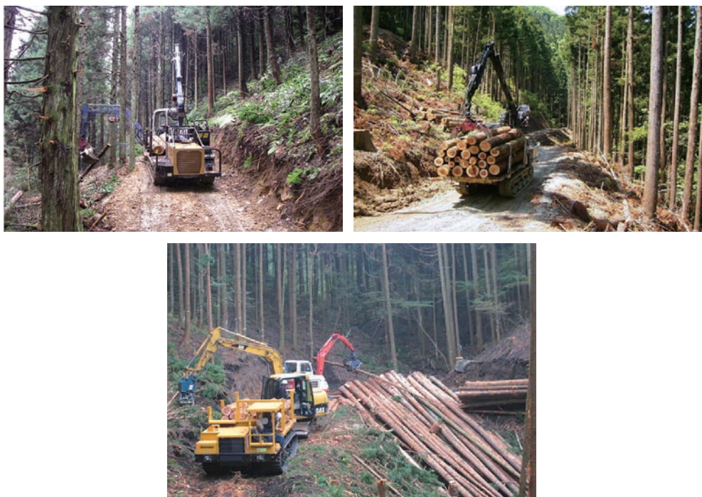
写真6-3 森林作業道(林業機械が集材作業等のため走行する)
