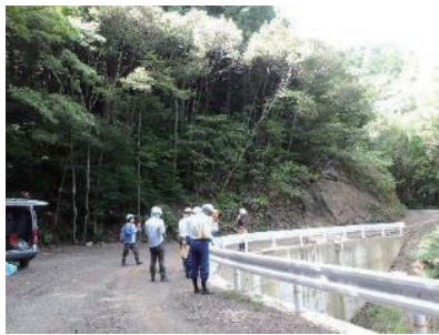
林道復旧工事現場確認
