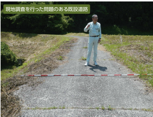
舗装が薄く大型トラックが通れない農道
