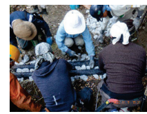
(作業道の路面の整備)
