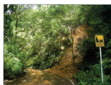
(崩落した土砂の撤去)
