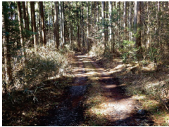
(砕石支給実施前)
