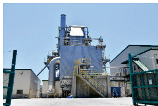
（木質バイオマス発電所外観）
