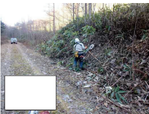
（路肩・法面伐開）
