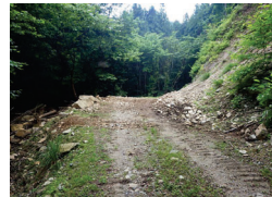
(路面補修工実施後)
