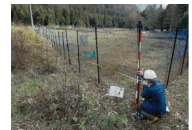
獣害防護柵設置（米子）
