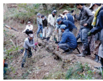
(作業道の路肩の整備)
