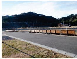
(釜石市設置状況)
