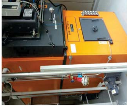
高原の宿氷太くんの チップボイラー (150kW)
