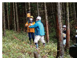
3Dレーザスキャナ操作
