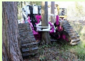
遠隔操作による伐倒作業
