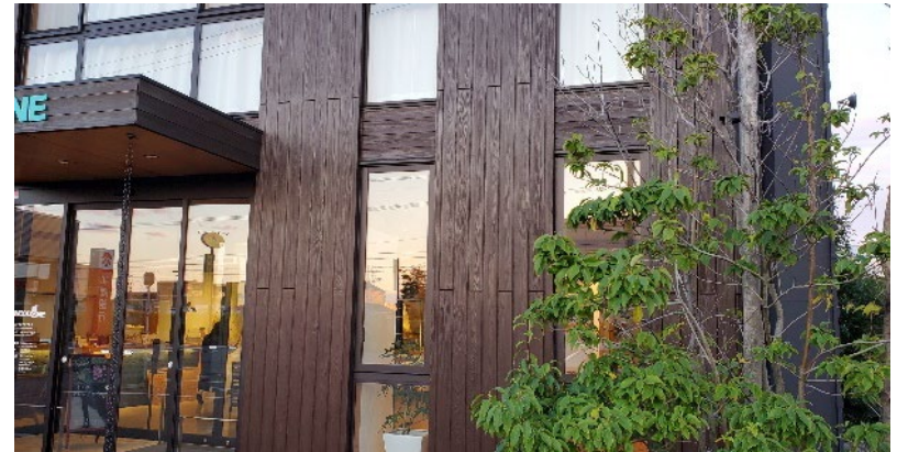
耐候性を有する上塗り用着色CNF塗料を使用した試験施工例
