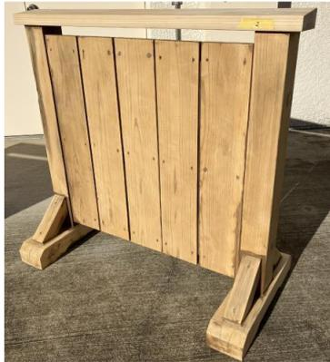
劣化塗膜除去、研磨後
