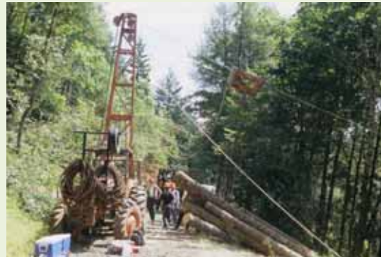
トラクタに装着されたタワーヤード
