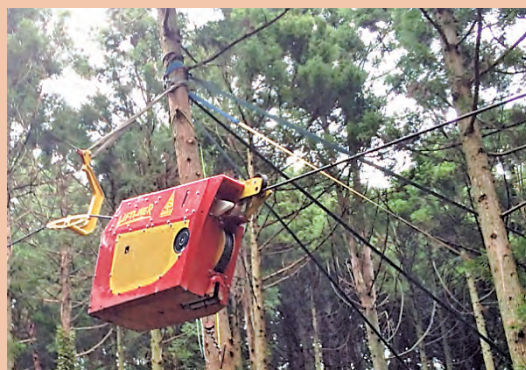
中間サポートの使用
