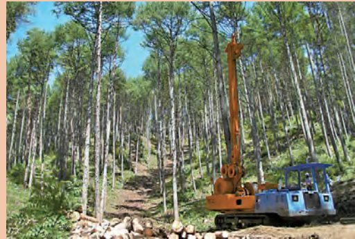
クローラ搭載型を搬入するための路網
