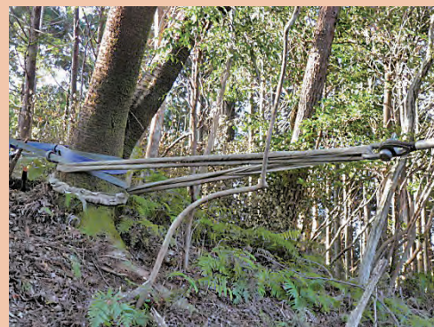
ラウンドスリング等で主索を固定
