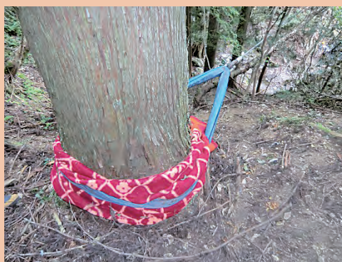
ラウンドスリングでガイラインを固定
