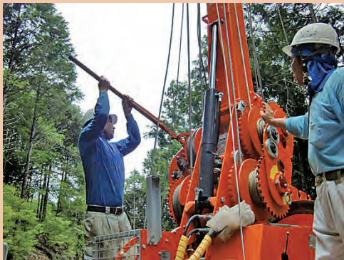
ガイライン用引締め作業
