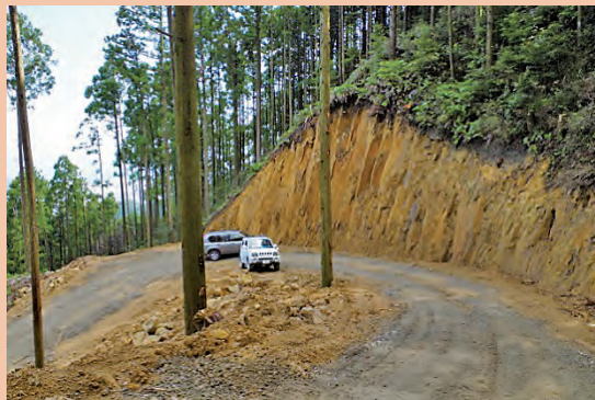
トラック搭載型を搬入するための路網
