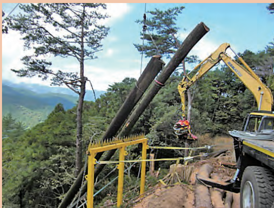
滑落防止柵を使用した作業
