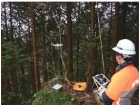
ドローンによる予備線の運搬
