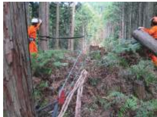
専用の滑車を用いリードロープとして利用
