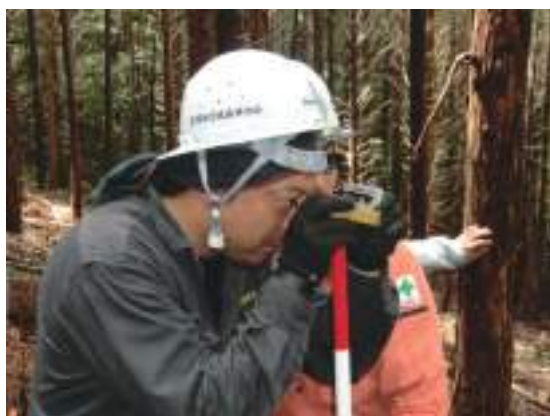
ハンドレベルを用いた縦断勾配の確認
