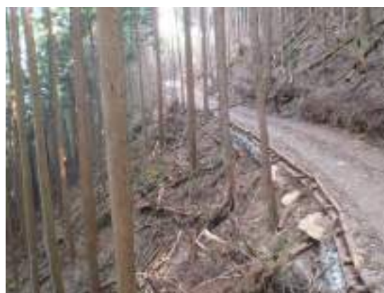
盛土部分に設置した丸太組
