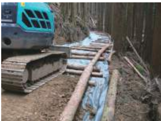
土木シートと丸太組による路面沈下の抑止 (黒ボク土)
