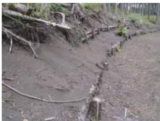
丸太柵による切土のり面の勾配緩和
