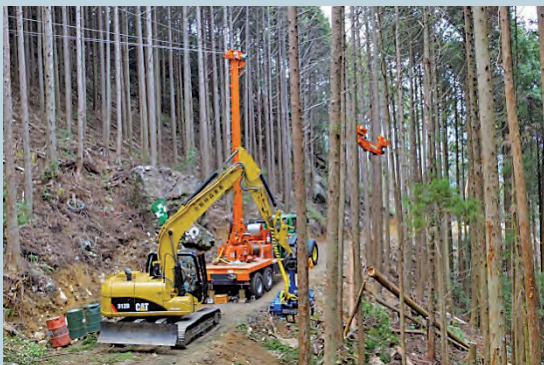
道路上に設置された中型タワーヤーダ
