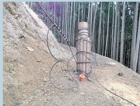
人工アンカーにより直接主索を固定
