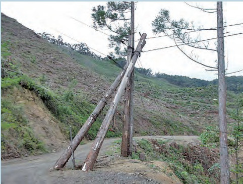
添え木による支柱の補強
