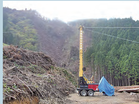
放射状に架設するため広い土場を選定
