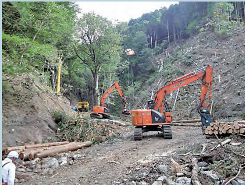
架設を繰り返すため路網を土場として選定
