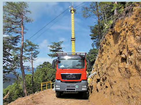
道路上に設置された大型タワーヤーダ
