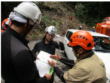
タワーヤーダ探索設置指導状況
