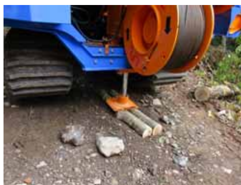
センターリガーによる固定
