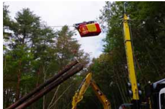
巻上索内蔵型搬器を用いた集材作業
