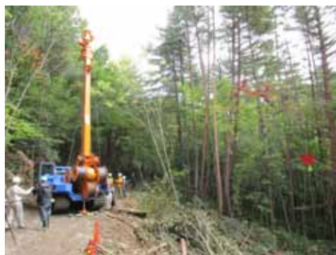
5 胴式タワーヤードによる集材作業
