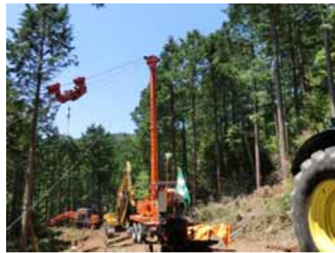
一連の作業風景
