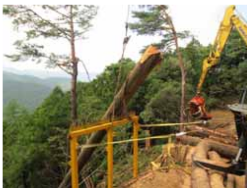
滑落防止柵を用いた集材作業
