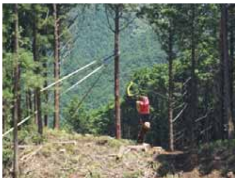
設置された中間サポート
