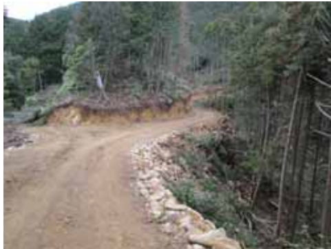
トラック搭載型を搬入するための路網
