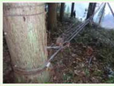
12 元柱側主索アンカーの設置状況(1)
