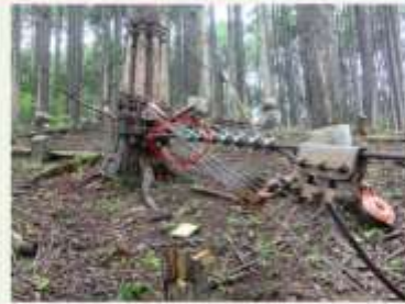
19 主索の元柱側での固定
