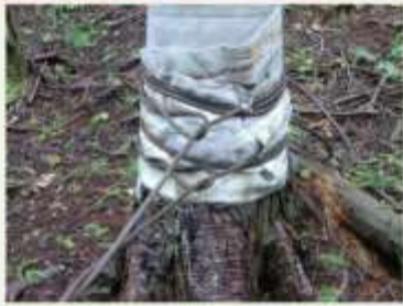
32 ガイラインの固定(アンカー側)(1)
