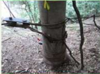
11 主索を曲げる器具の設置状況
