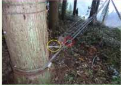
18 主索の元柱側での固定
