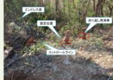
29 コントロールラインの取り付け
