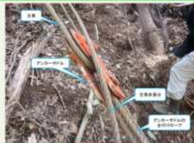
13 元柱側主索アンカーの設置状況(2)
