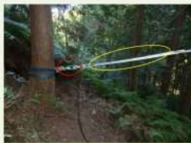
35 ガイラインの緊張(ターンバックル)
