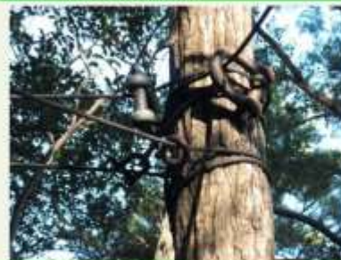
14 ガイラインの設置状況(1)
