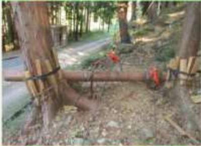
17 向柱の設置状況
