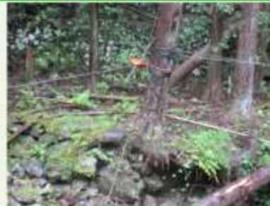
16 支柱の設置状況
