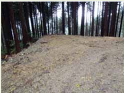
尾根部の路網を拡幅した方向転換地点
