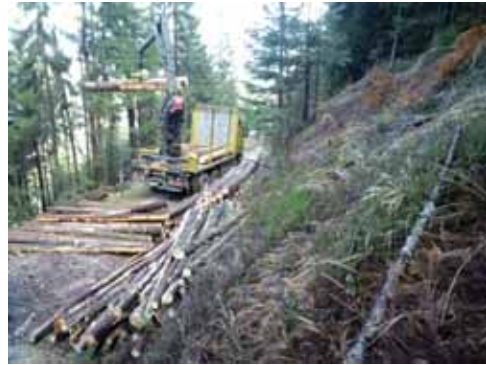
グラップルローダ付トラックでの積み込み
