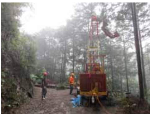
小型タワーヤードの使用を想定した路網
