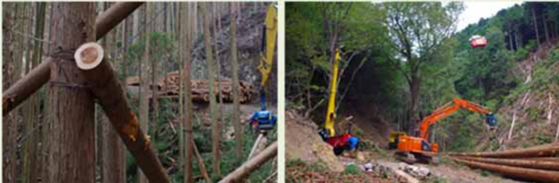
横木による材の方向転換（上げ荷）
