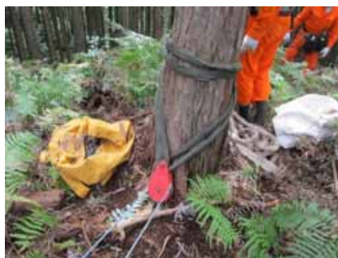
リードロープ用ガイドブロックの設置
