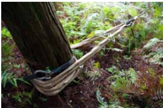
ラウンドスリングでガイラインを固定
