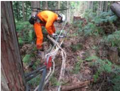
主索のシンブル部をシャックルで固定
