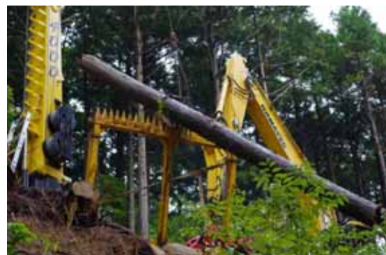
荷外し場所に設置した滑落防止柵
