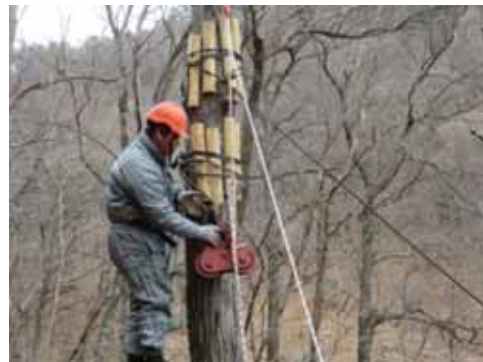
取り付け中もロープで器材重量を支える
