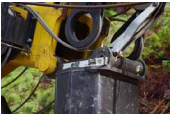
水準器で土台の水平を確認
