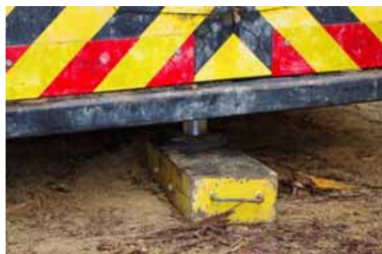
リガーの接地部に角材等を敷設
