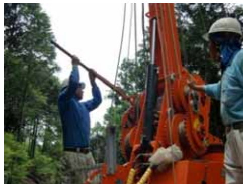
ガイラインの張り上げ作業
