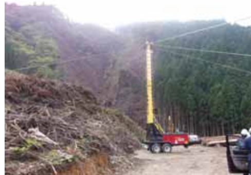
完全に吊り上げた状態での集材作業
