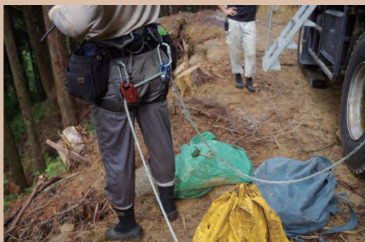
繊維製リードロープを腰部の滑車で引き回し
