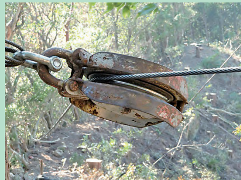
側板を補強したガイドブロック
