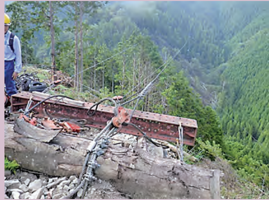
埋め込みアンカーの作設例
