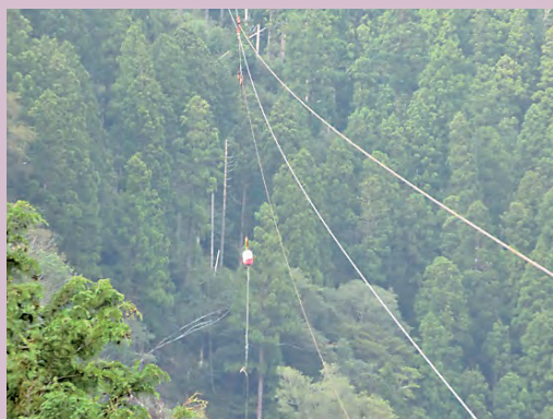
目立つ色を重錘に塗ってロージングブロックの位置を確認
