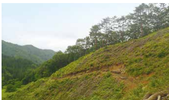
【写真1】皆伐実施後の様子(南会津町)
