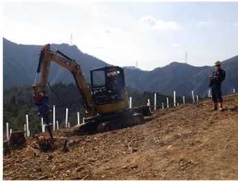
高所無人掘削機+根株ドリル
