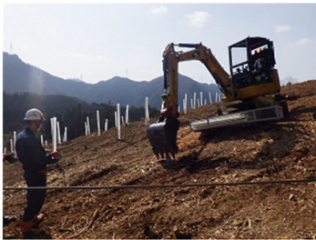
高所無人掘削機+造林開発器具
