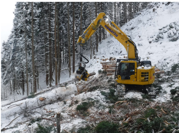
【大型機械による造材作業】
