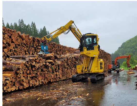
【エレキャブによる巻き立て作業】
