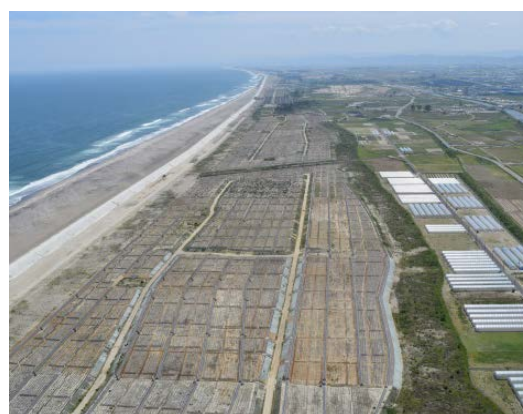
写真2 海岸防災林の復旧・再生状況 (宮城県仙台市)
