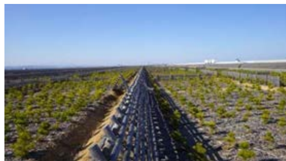
写真 i 海岸防災林再生事業（植栽工） （宮城県山元町）
