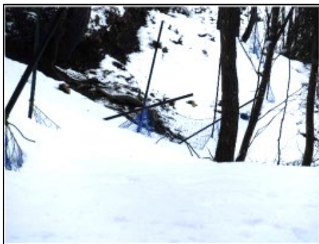
写真コ-1, 2 積雪による防護柵の破損状況
