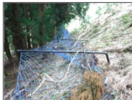
写真コ-1, 2 積雪による防護柵の破損状況
